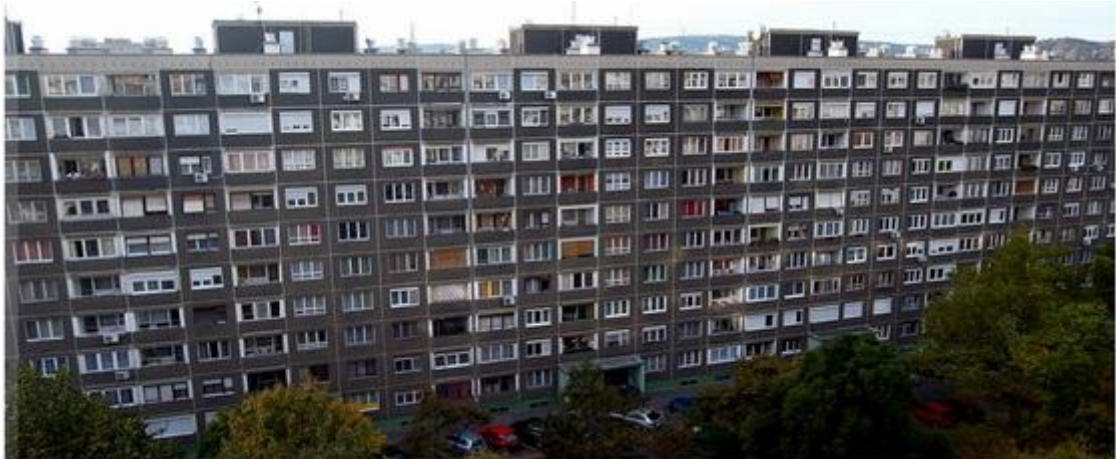
1. kép: panelépület meglévő homlokzata
